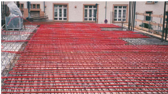
5 Рис. 4: Модуль ВКТ RENAU, закладываемый в перекрытие
