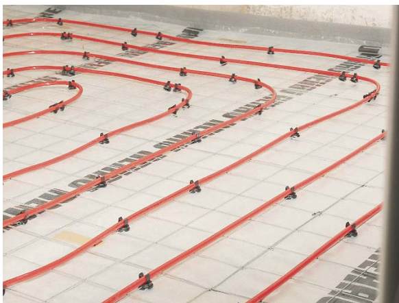
1 Рис. 28: Монтаж по технологии REHAU на арматурной сетке
