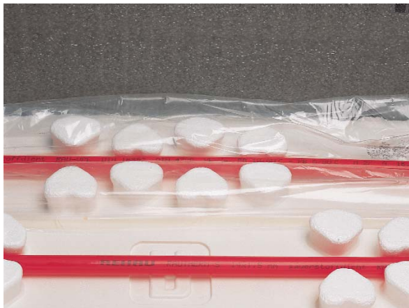
1 Рис. 14 Маты с фиксаторами vario
