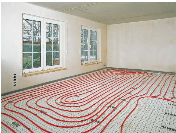
1 Рис. 15: Монтаж на матах с креплением трубы гарпун-скобой
