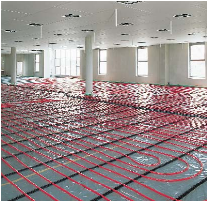
1 Рис. 3: Фиксирующие шины REHAU RAUFIX
