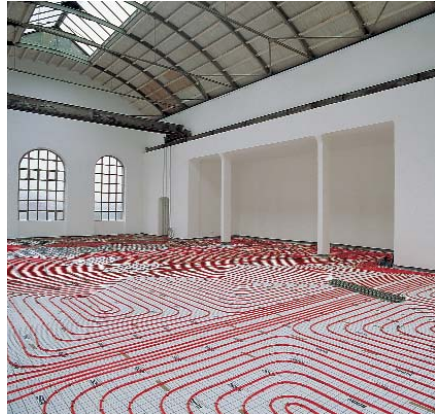
1 Рис. 2: Система крепления труб с помощью гарпун-скоб REHAU
