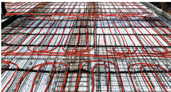
5 Рис. 6: Модули ВКТ RENAU, уложенные на месте перед бетонировкой перекрытия
