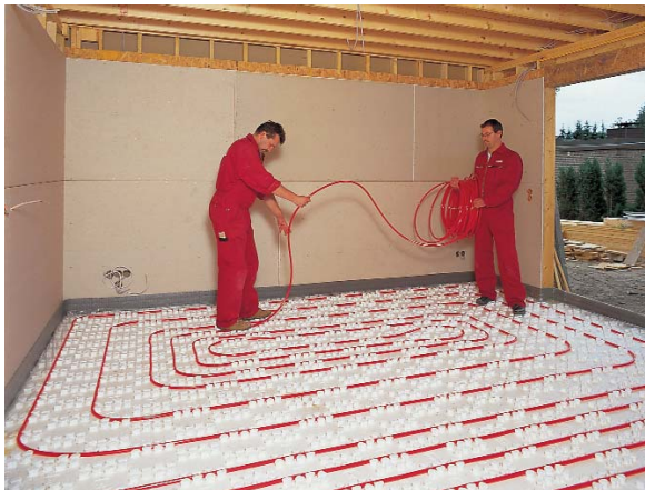
1 Рис. 9: Монтаж на матах с фиксаторами vario
