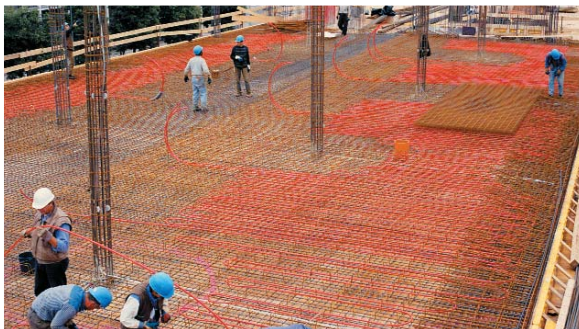
5 Рис. 5: Модули ВКТ RENAU, укладываемые на месте.
